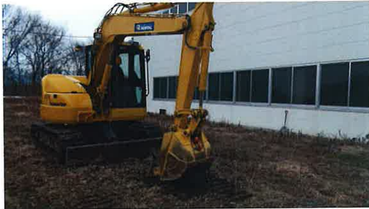
【バックホウによる汚染土壌の採取】
