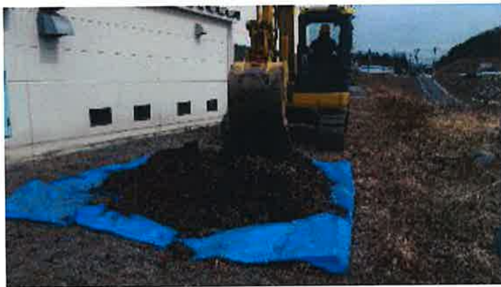
【バックホウによる汚染土壌の採取】
