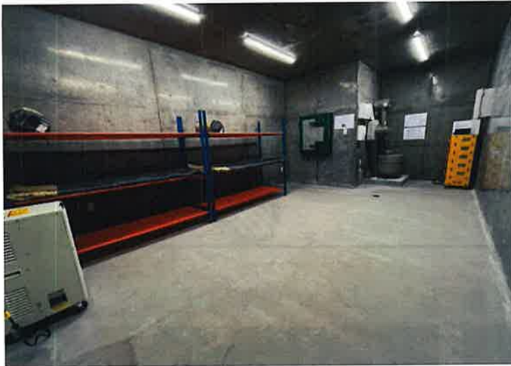
【シェルター内部】
