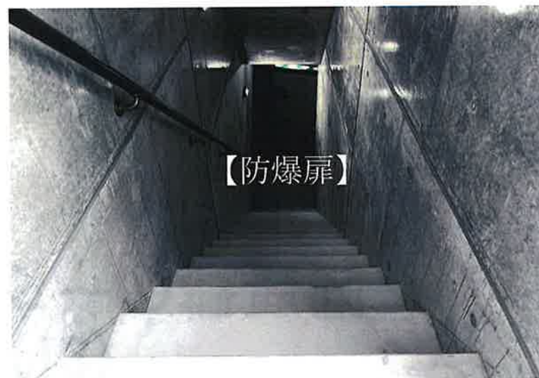
【防爆扉への階段（進入路）】
